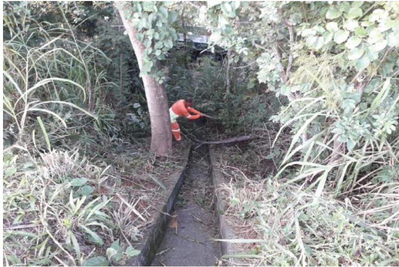
Foto 6 – Limpeza de descida d'água – Km 01+600 Norte
