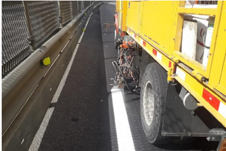
Foto 1 – Pintura de faixas – Km 10+800 Norte
