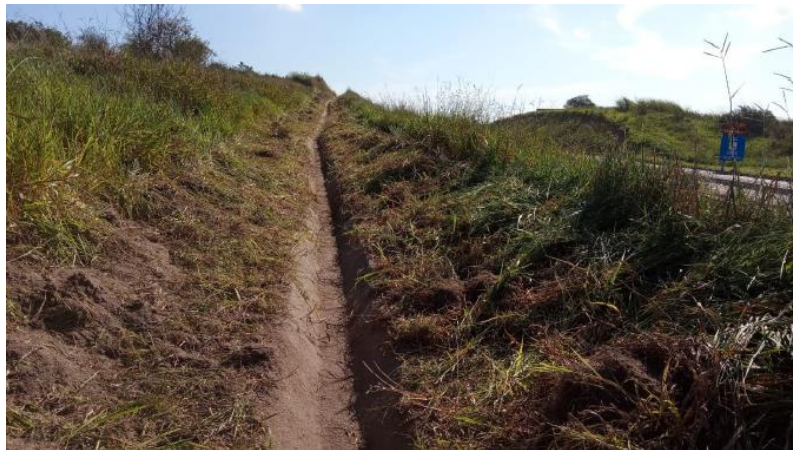
Foto 7 – Limpeza de valeta de corte – Km 47+300 Norte
