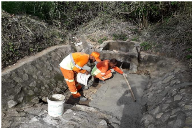
Foto 8 – Reparo da caixa coletora – Km 18+900 Norte
