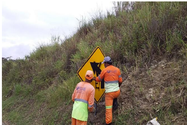
Foto 2 – Reparo de placa – Km 55+200 Norte
