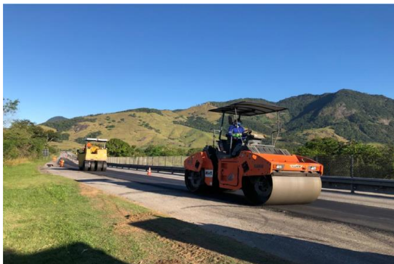
Foto 14 – Recuperação do pavimento – Km 16+000 Sul
