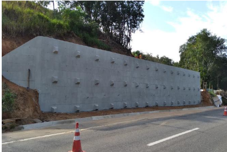
Foto 12 – Obra de recuperação de talude – Km 15+700 Sul
