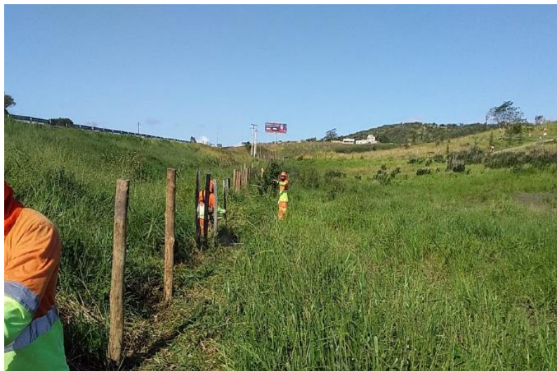
Foto 10 – Reparo de cercas limítrofes – Km 54+400 Norte
