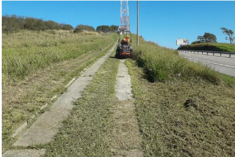
Foto 9 – Roçada mecânica – Km 44+400 Norte
