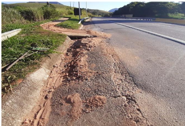
Foto 5 – Limpeza da sarjeta – Km 19+600 Norte
