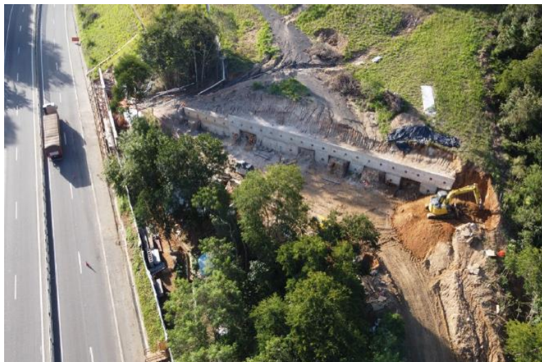
Foto 13 – Obra de recuperação de talude – Km 15+700 Sul [2]
